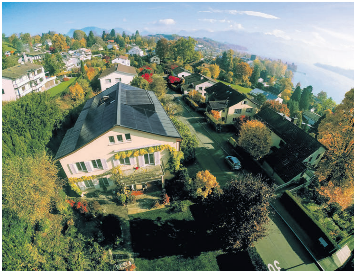
Gutes Beispiel für eine nachhaltige Gebäudesanierung: Mehrfamilienhaus im Bellerive-Quartier in Luzern.
