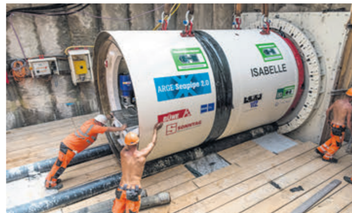
... für das Microtunneling.
