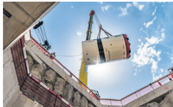
Installation des Bohrkopfs am Seeufer (Bild links und oben)...
