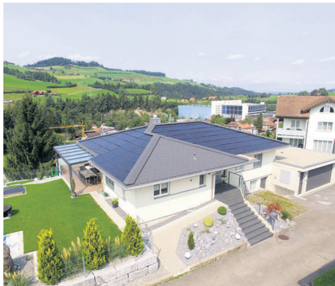
Die Basis für «Smart Energy» bildet die Stromproduktion auf dem eigenen Hausdach.
