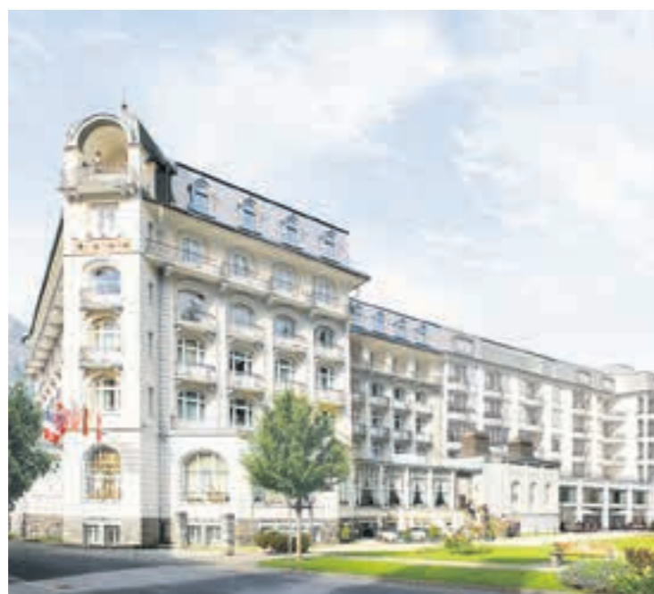
Neue Impulse für die Zentralschweizer Hotellerie: das sich im Bau befindende Hotel Titlis Palace in Engelberg ...
