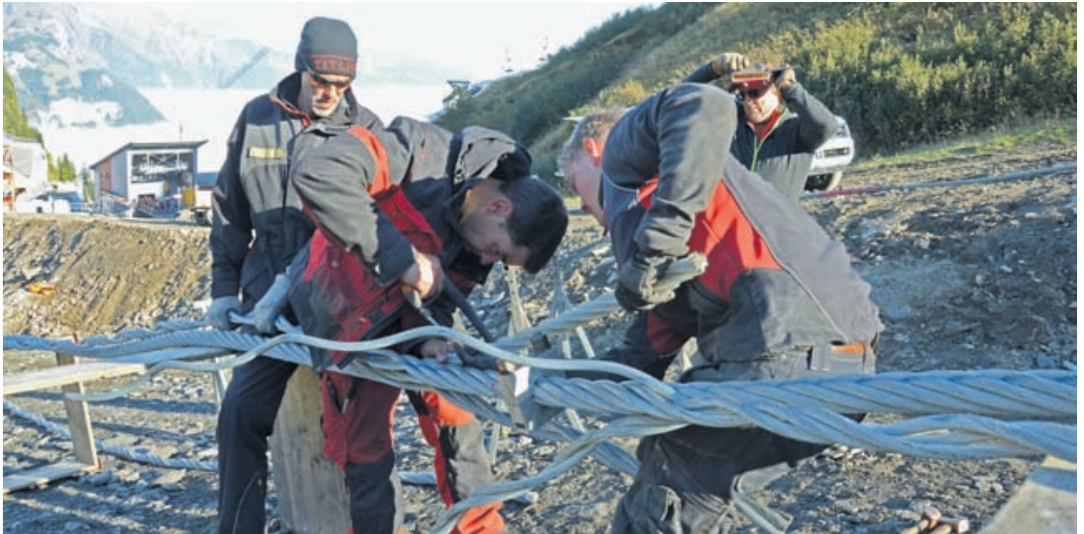
Seilspleissen ist reine Handarbeit. Die einzelnen Litzen an den beiden Seilenden werden ineinander verwoben, sodass ein Endlosseil entsteht.
