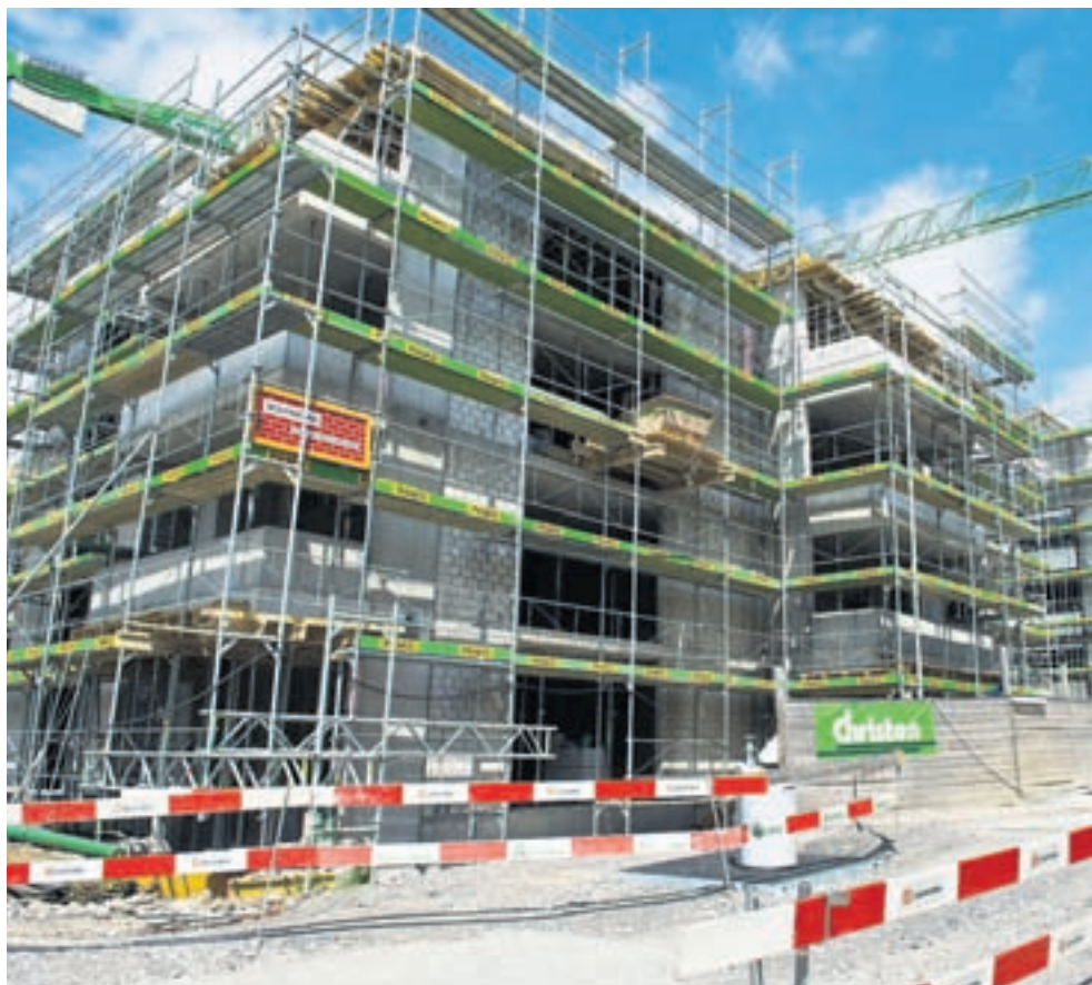
In der Zentralschweiz wird weiterhin kräftig gebaut.
