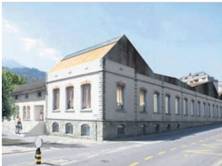
Kultur- und Jugendzentrum im alten Feuerwehr-/Werkhofgebäude.
