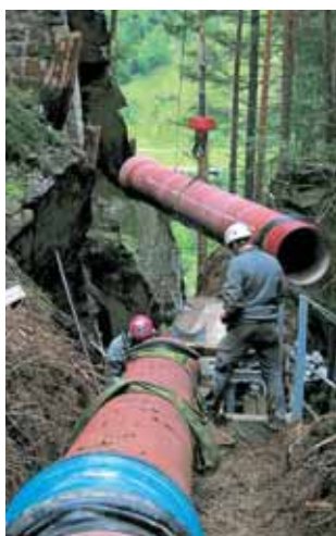
Exaktes Arbeiten zählt: bei der Verlegung der neuen Druckleitung.
