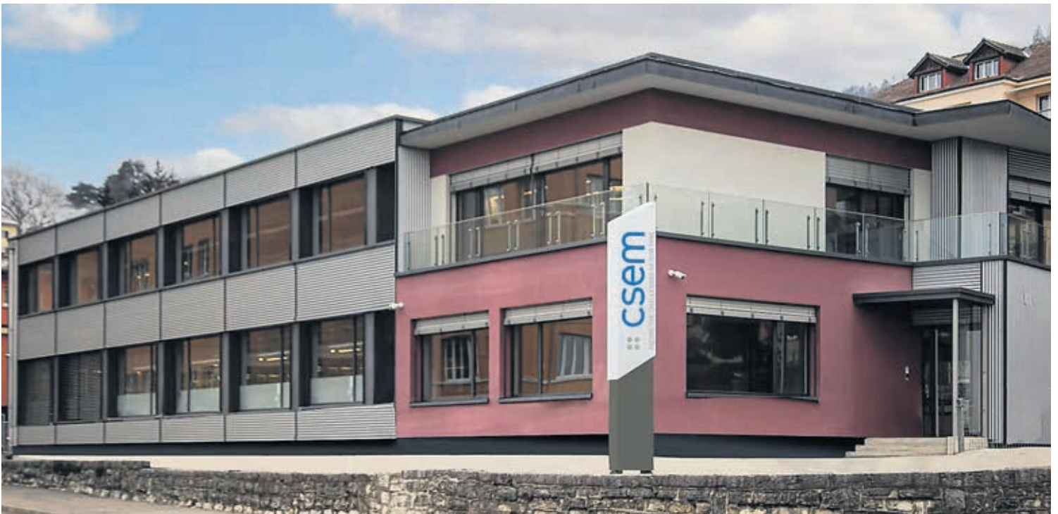
Am CSEM entsteht ein neues Zentrum für die Entwicklung neuer Technologien rund um Batterien für die Energiewende.
