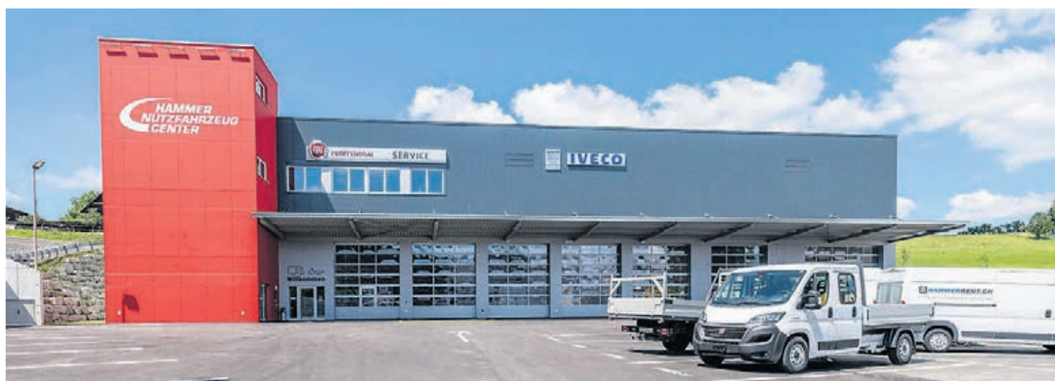
Das Nutzfahrzeug Center wurde 2020 in Betrieb genommen.
