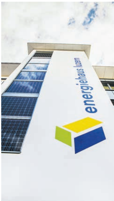
Energiehaus Luzern: Sitz der BE Netz und Plattform für Wissensaustausch.
