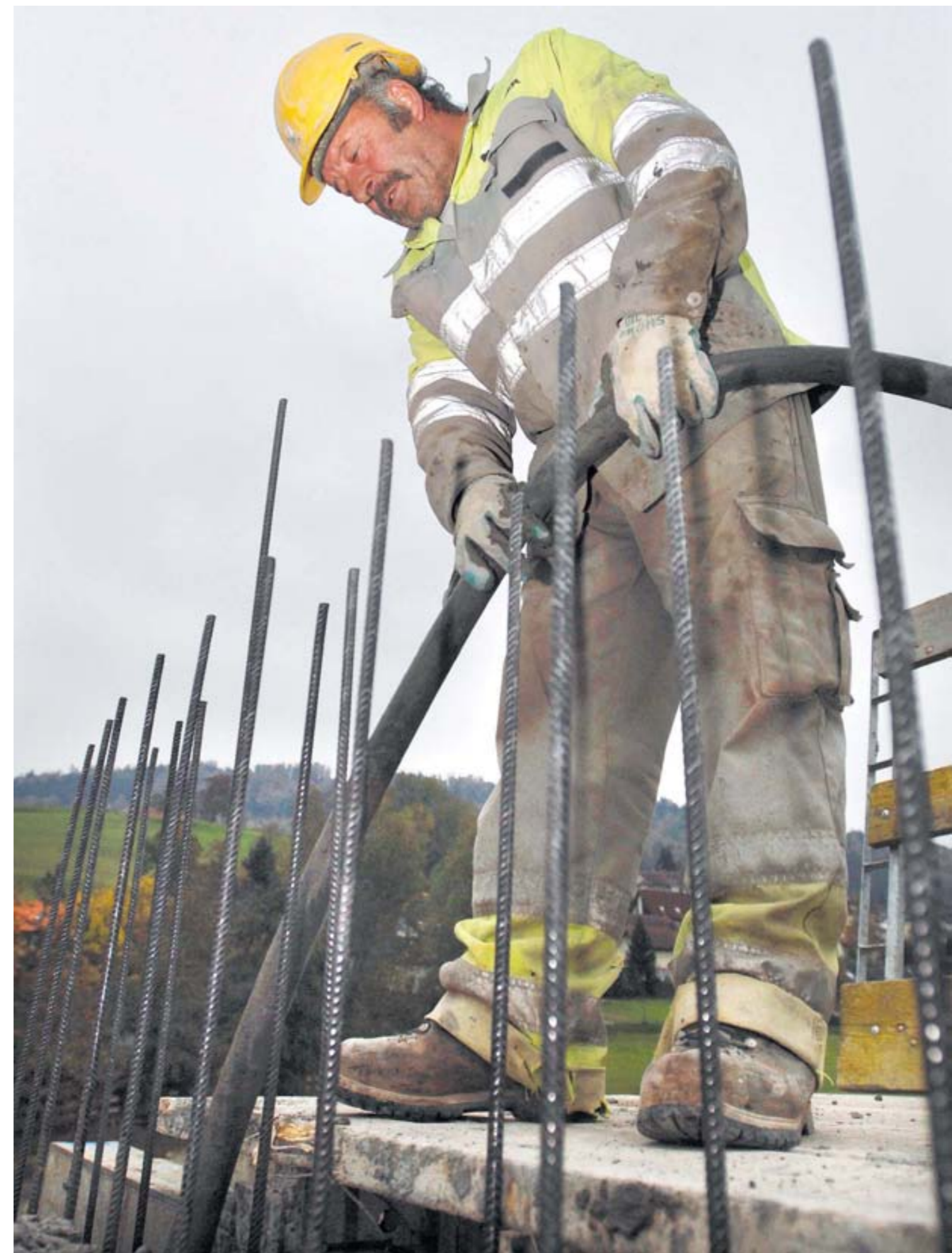
Alle Hände voll zu tun: Auf den Baustellen gibt es derzeit viel Arbeit.
