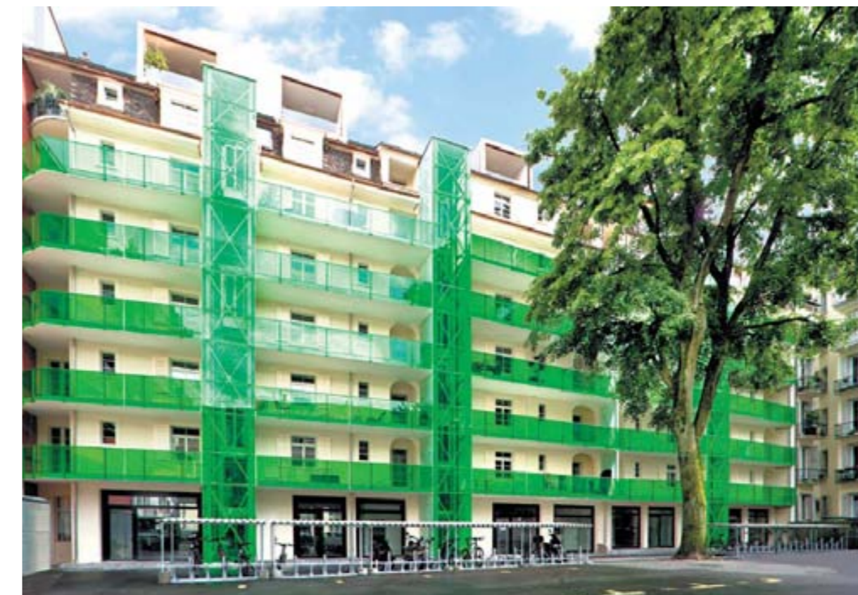
Verbindung von Alt und Neu: Innenhof an der Habsburgerstrasse in Luzern.
